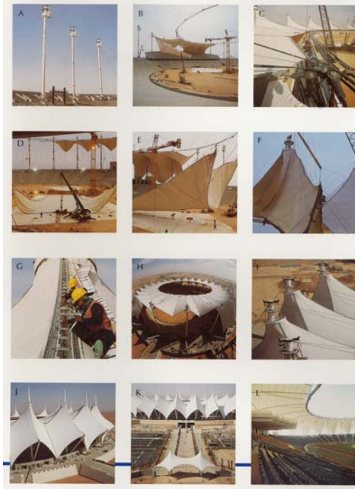
Şekil 2. Yük ve gerilim taşıyabilen inşaat tekstilleri örnekleri (Adanur, 1995)
