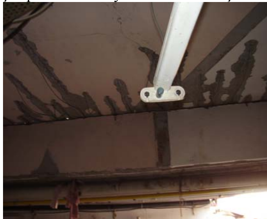
Şekil.13,14.Teknik ofis Elektrik panosu durumu,Asma tavan üstü hasarlı betonarme yapı
