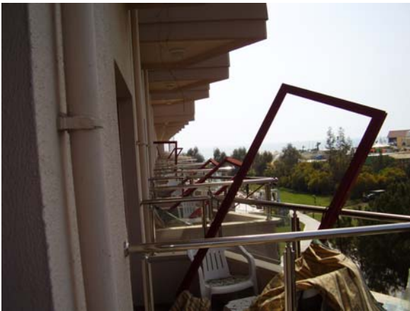
Şekil 21,22.Otele ait balkon kapıları ile pencerelerin patlama sonrası durumu
