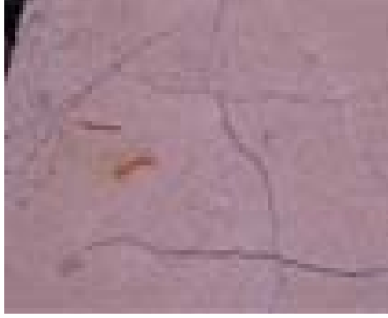
Şekil 7. Rize ili Çayeli ilçesi özel bina döşeme betonu görüntüsü
