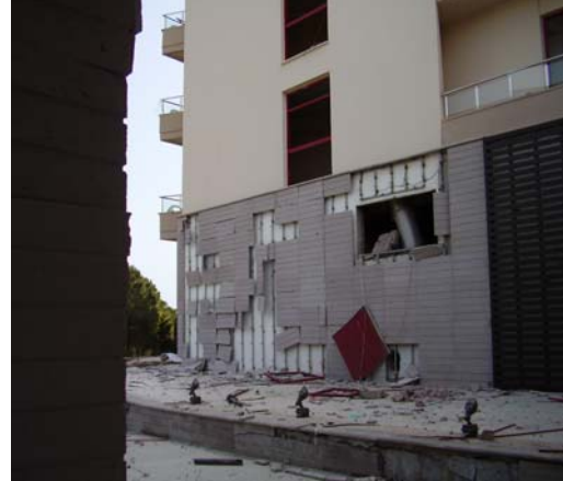
Şekil 21,22.Otele ait balkon kapıları ile pencerelerin patlama sonrası durumu
